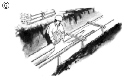
Las ayudas temporarias de los caños (hay que quitarlos)
